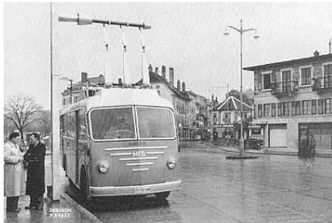
**Bild 7-18:** Prototyp eines Gyrobusses mit 74 kW um 1950 in Yverdon (Schweiz) beim „Auftanken“ mit Drehstrom an der Endhaltestelle
