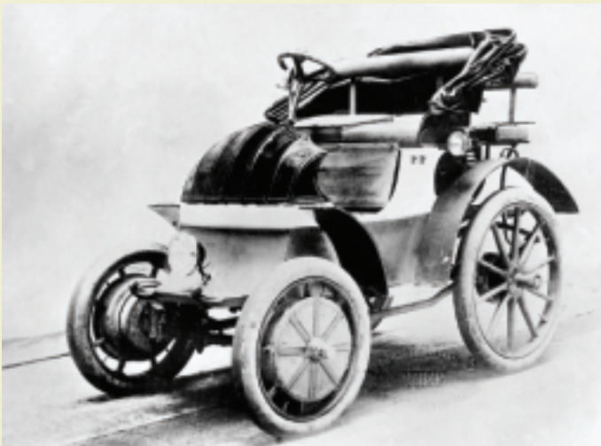
Abb. 1: Elektrofahrzeug 1900: Der Lohner-Porsche mit Radnabenmotoren auf der Weltausstellung 1900 in Paris, 50 km/h Höchstgeschwindigkeit, ca. 50 km Reichweite.
